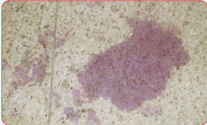
Nicht mehr entfernbare Tiefengrundflecken
